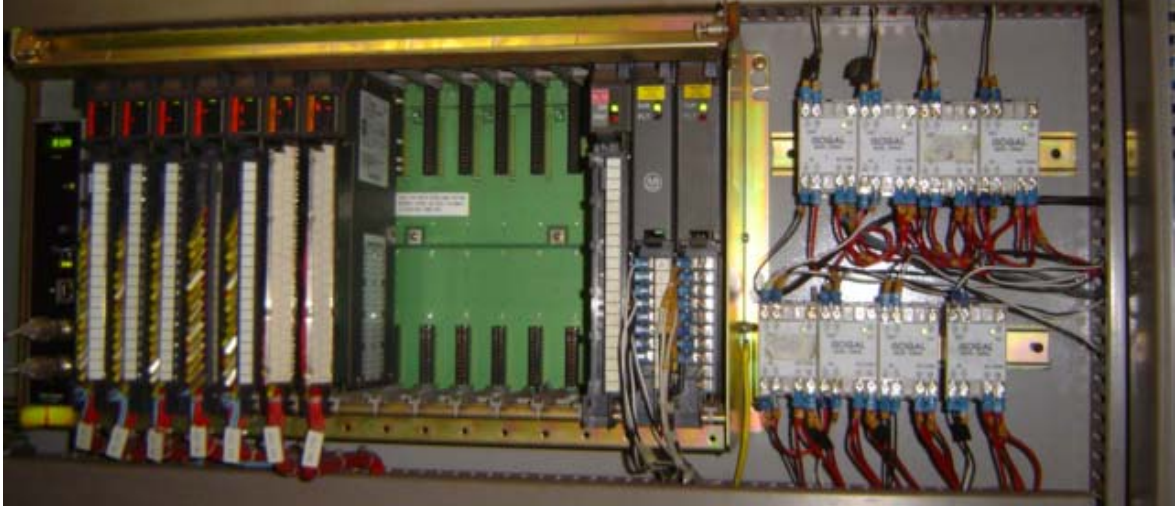
Figura 11 – Visão frontal do PLC com os cartões e isoladores de sinal.
