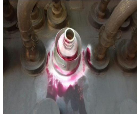
b) Compensador novo instalado
