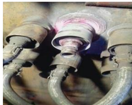
d) Etapa de soldagem do compensador
