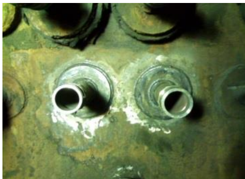
c) Etapa de soldagem do tubo
