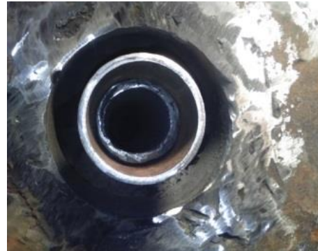
b) Etapa de soldagem da luva
