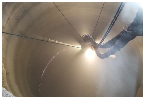
b) projeção robotizada na coroa de choque e cuba
