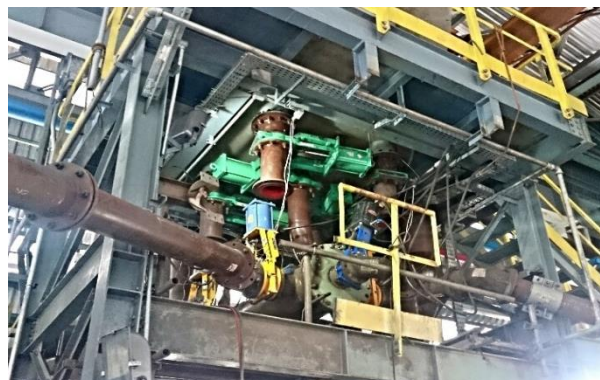
Figura 11(b). Montagem do distribuidor
