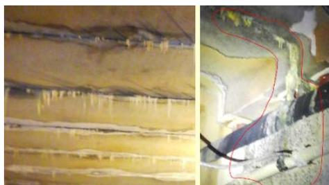
**Figura 12.** Estrutura Civil da Sala de Cubas Eletrolíticas com sulfatação nos isoladores.
