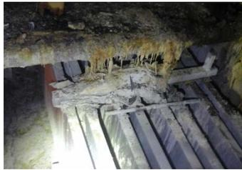
**Figura 10.** Imagem de parte da Galeria de Barramentos com concentração de sulfatação gerando caminhos para fuga de corrente.
