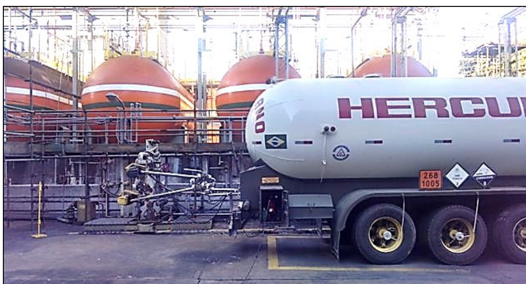
Figura 2. Vista parcial dos tanques de estocagem de amônia anidra e área de carregamento de caminhão na Usiminas.
