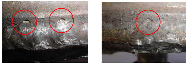
Figura 4. Macrografias mostrando presença de mordeduras no cordão de solda que une a placa de fixação à mesa do semi-reboque
