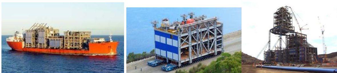
Figura 14. Transporte e montagem de módulos. (8)
