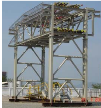
Figura 3. Exemplos de unidades pré-montadas e instalação no local da planta. (8)
