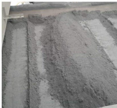
Figura 7 - Material não compactado na Máquina
