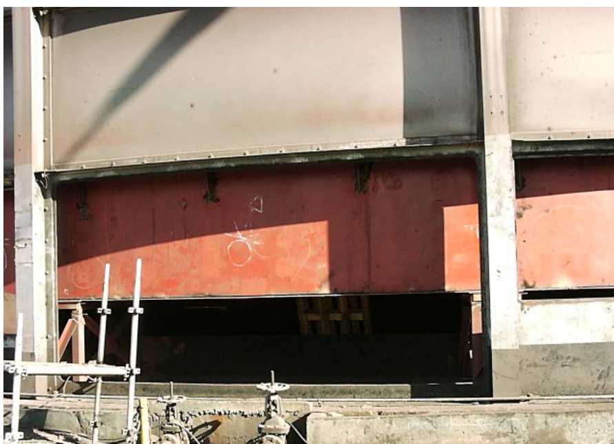
Figura 5. Chapas metálicas soldadas à estrutura original. As novas chapas foram receberam pintura de fundo (primer), antes de serem soldadas.
