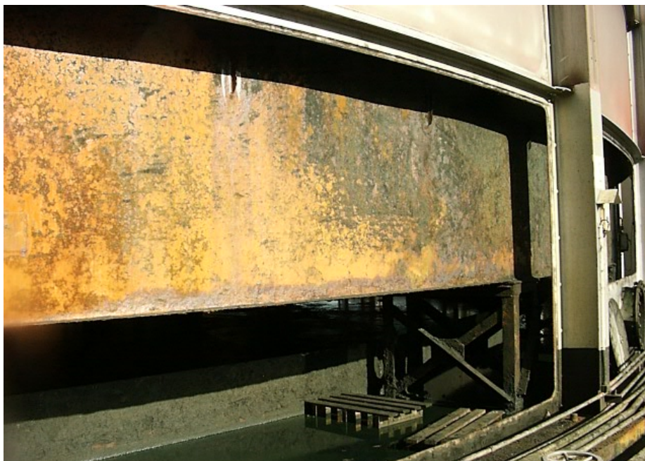
Figura 6. Abertura do anel de base, de modo a deixar exposto o “footring”.
