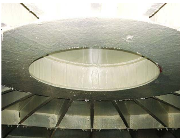
Figura 9. Revestimento da parte inferior do pistão – vista do teto
