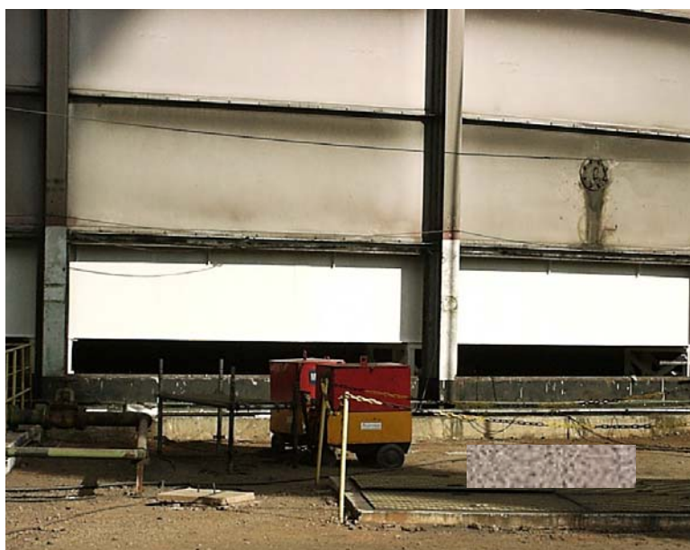
Figura 7. Revestimento aplicado nas chapas após serem soldadas ao “footring”
