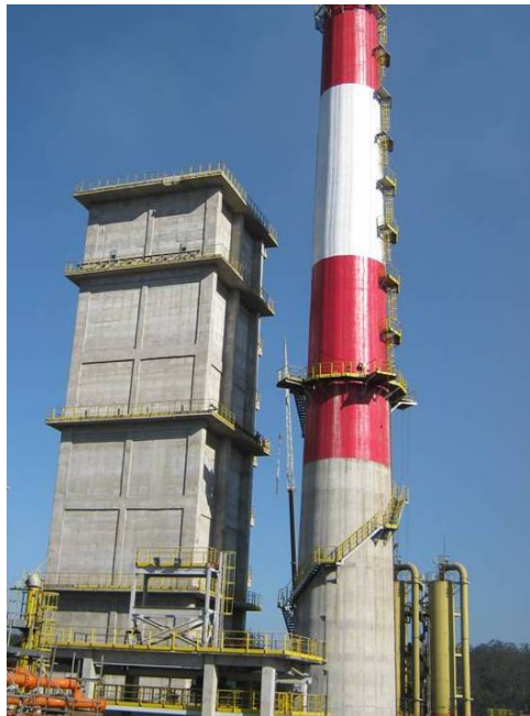
Figura 13. Torre de extinção de coque.
