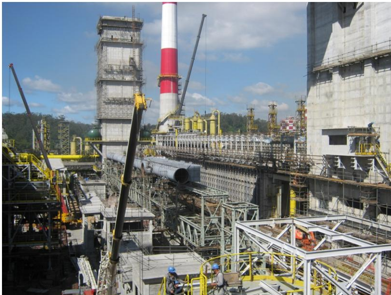
Figura 4. Montagem dos equipamentos periféricos da coqueria.
