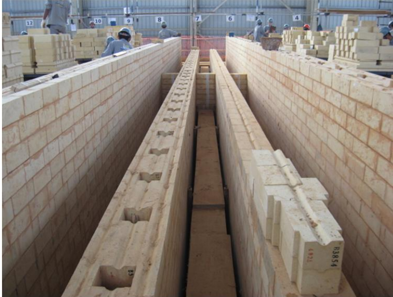
Figura 3. Montagem dos refratários.
