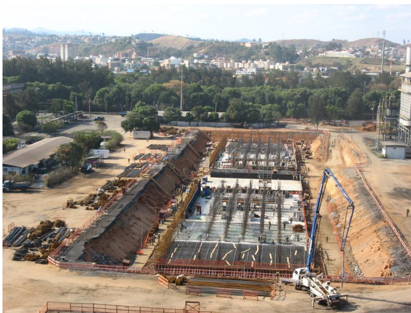
Figura 2. Obra civil da fundação das baterias.
