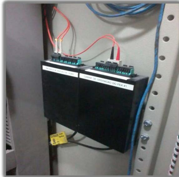
**Figura 12.** Painel novo, conversor fibra ótica.
