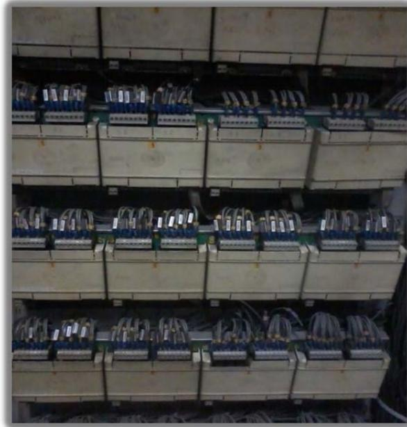
**Figura 8.** Painel antigo, com cabos identificados.
